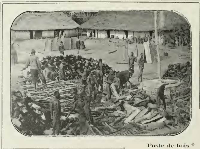
Poste de bois *
